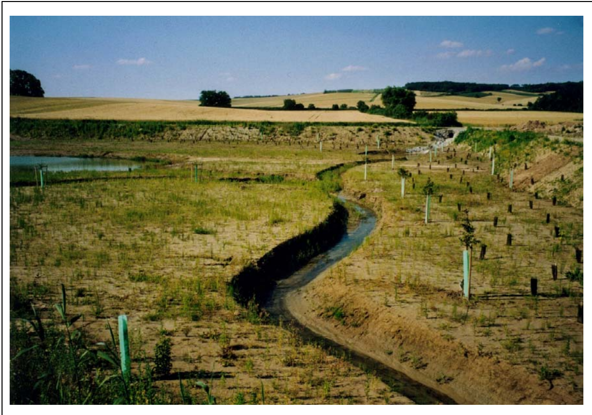
Abb.37: Künstlich angelegtes Feuchtbiotop mit Rückhaltefunktion entlang des Runzenbaches bei Groß
